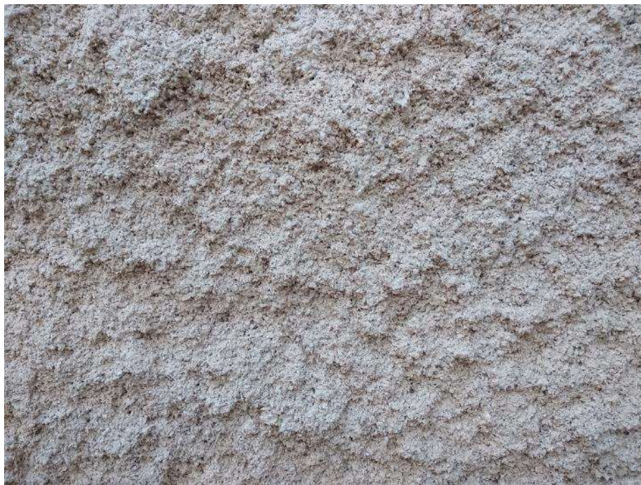
Foto 52. Llana de roca amb calç projectada a Unicmall. Font: Pròpia (2022).
